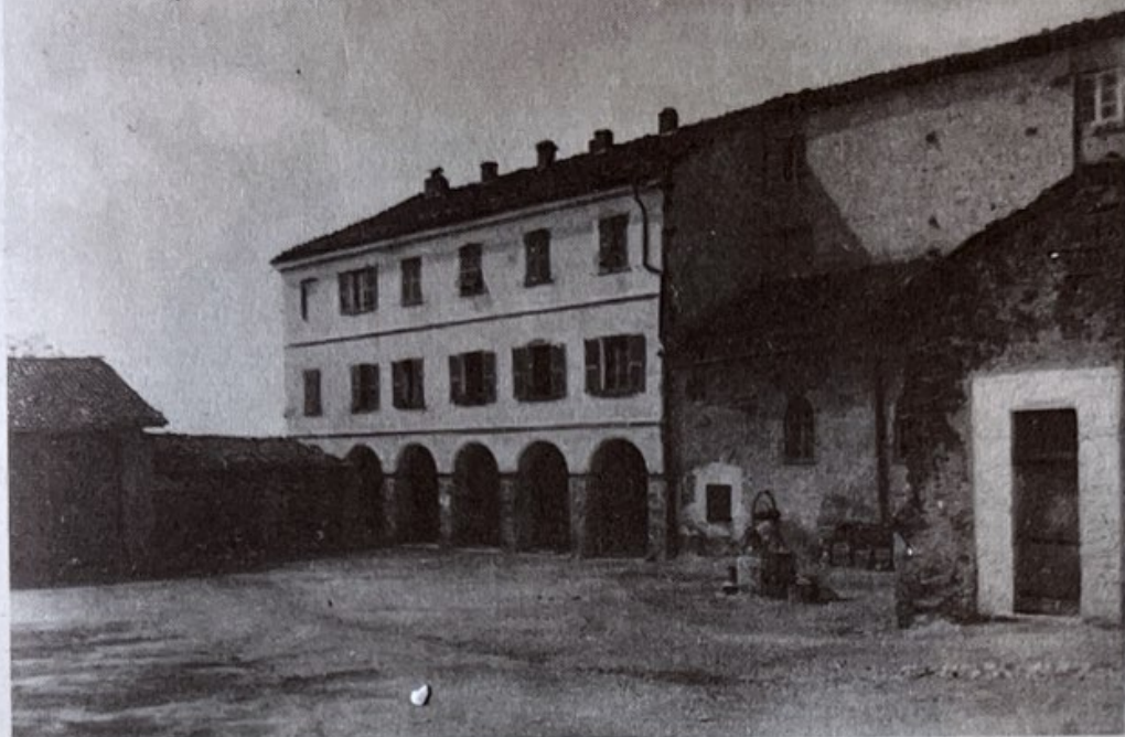
↑ L'antico Collegio: prospetto sud con la Cappella andata distrutta all'inizio dei restauri. Prospetto nord. ↗
