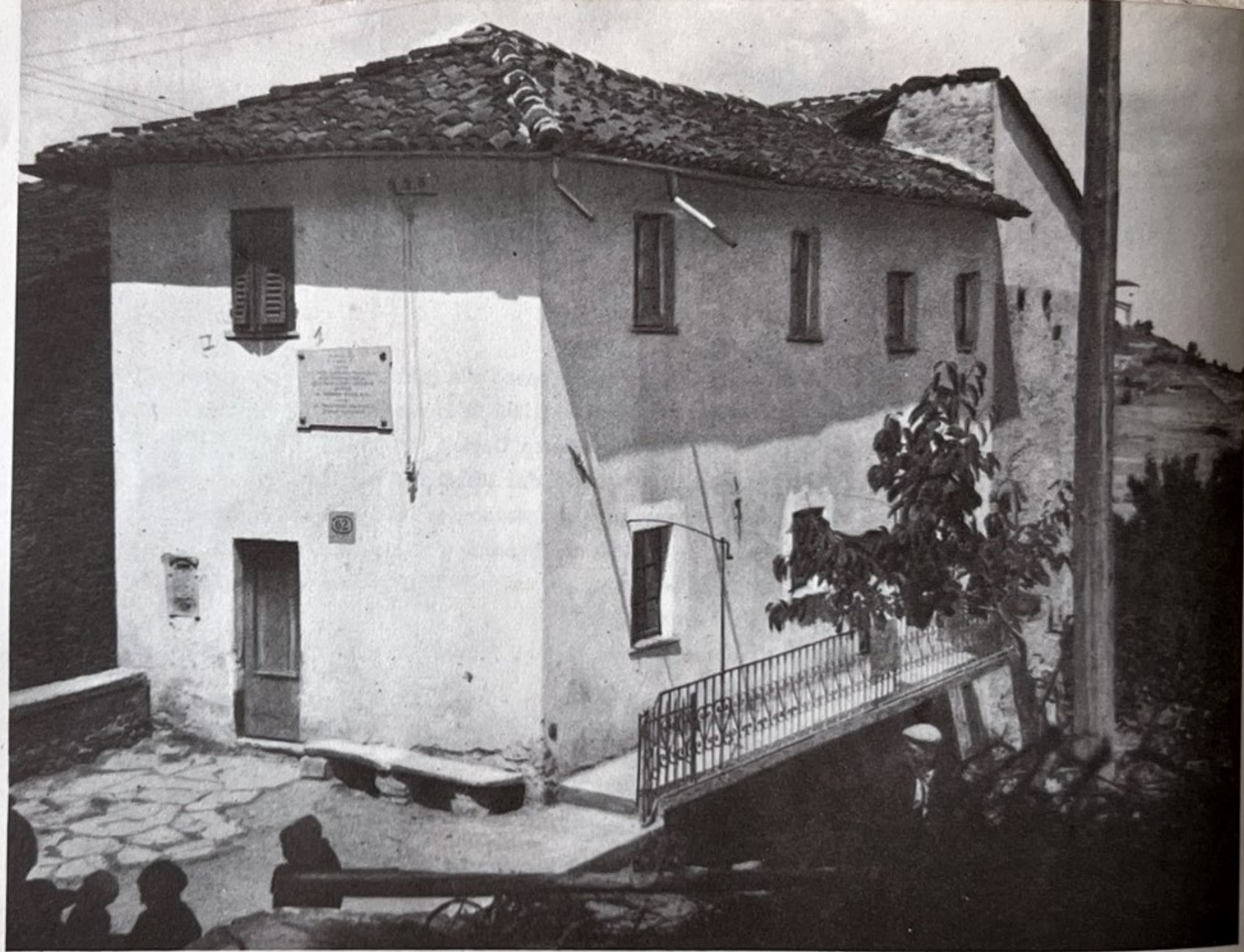
La casa dove nacque la Santa: facciata e fianco.
